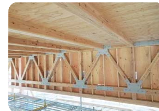
■ 屋根裏・壁内部：木材を利用した構造
